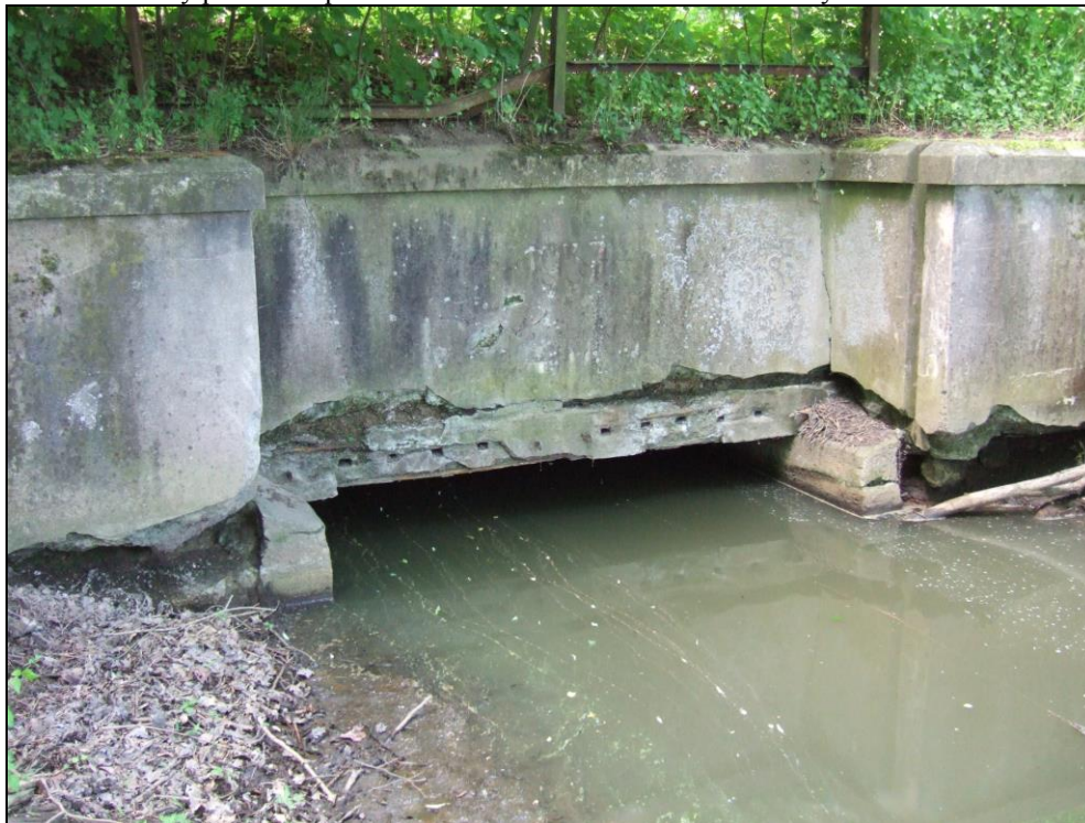
Obr. 3: Celkový pohled na poškozenou vtokovou část Černské strouhy
